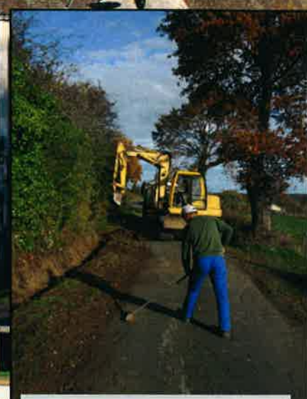
Entretien des fossés par l'entreprise Buguellou
