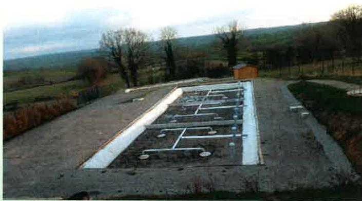
*Depuis Septembre les habitants du Village de Mont peuvent se raccorder au réseau d'assainissement collectif réalisé par la C.A.M ; Structure conçue dans un souci écologique avec plantation de roseaux.*
