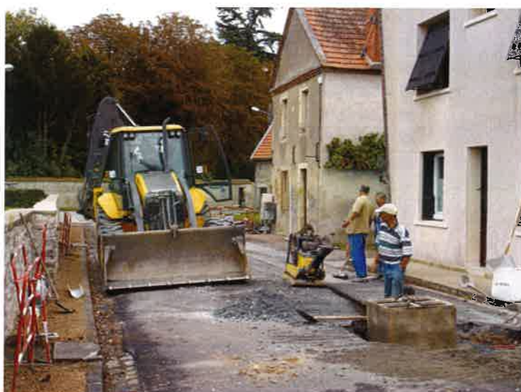
Travaux d'assainissement dans le bourg
