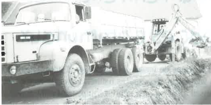
▲ Curage de fossé au Breuil
