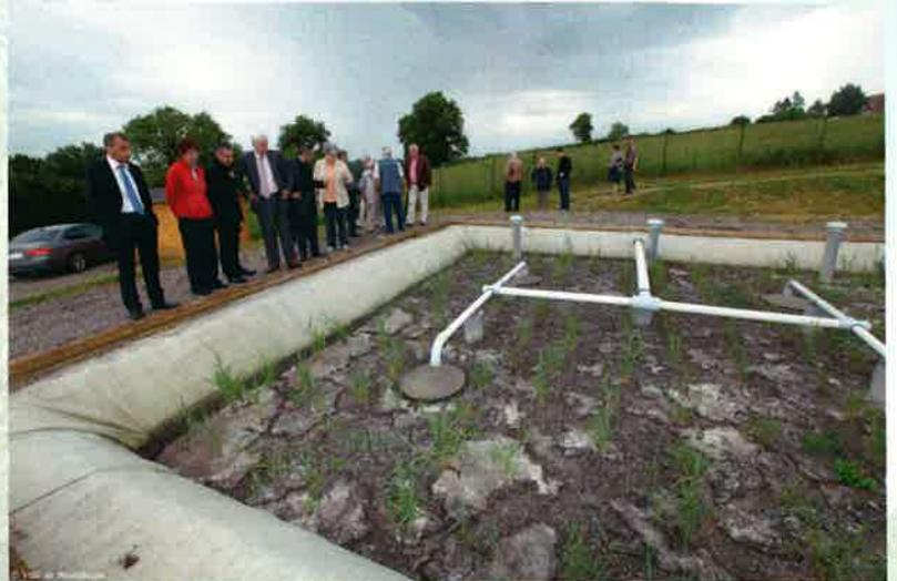
Implantée en contre-bas du village sur un terrain de 2000m<sup>2</sup>, la station d'assainissement est équipée de deux filtres plantés de roseaux. Elle permet de traiter les eaux usées des 25 habitations du village.
