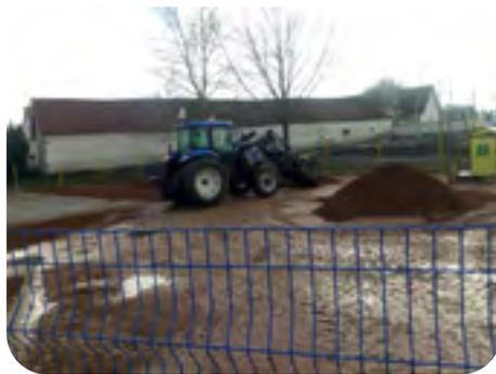
La cour de l'école, du fait de la présence de nombreuses flaques d'eau par temps de pluie, était devenue difficilement praticable. Nous avons décidé de recharger la couche de tuf afin de retrouver une certaine planéité de surface. Le volume de tuf nécessaire pour arriver à un résultat satisfaisant fut très important. Nous devons souligner le travail réalisé par nos agents, et remercier tout particulièrement l'entreprise SMC pour son aide.
